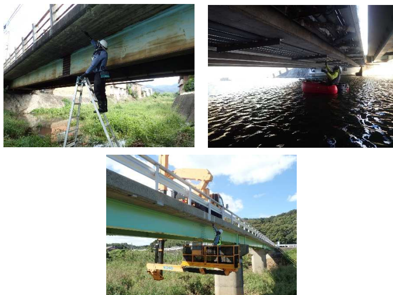
図 3.1 定期点検の様子
